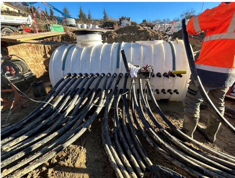
Figure 47 : Exemple d'un ensemble cuve/collecteur enterré 38 sorties en cours de raccordement
